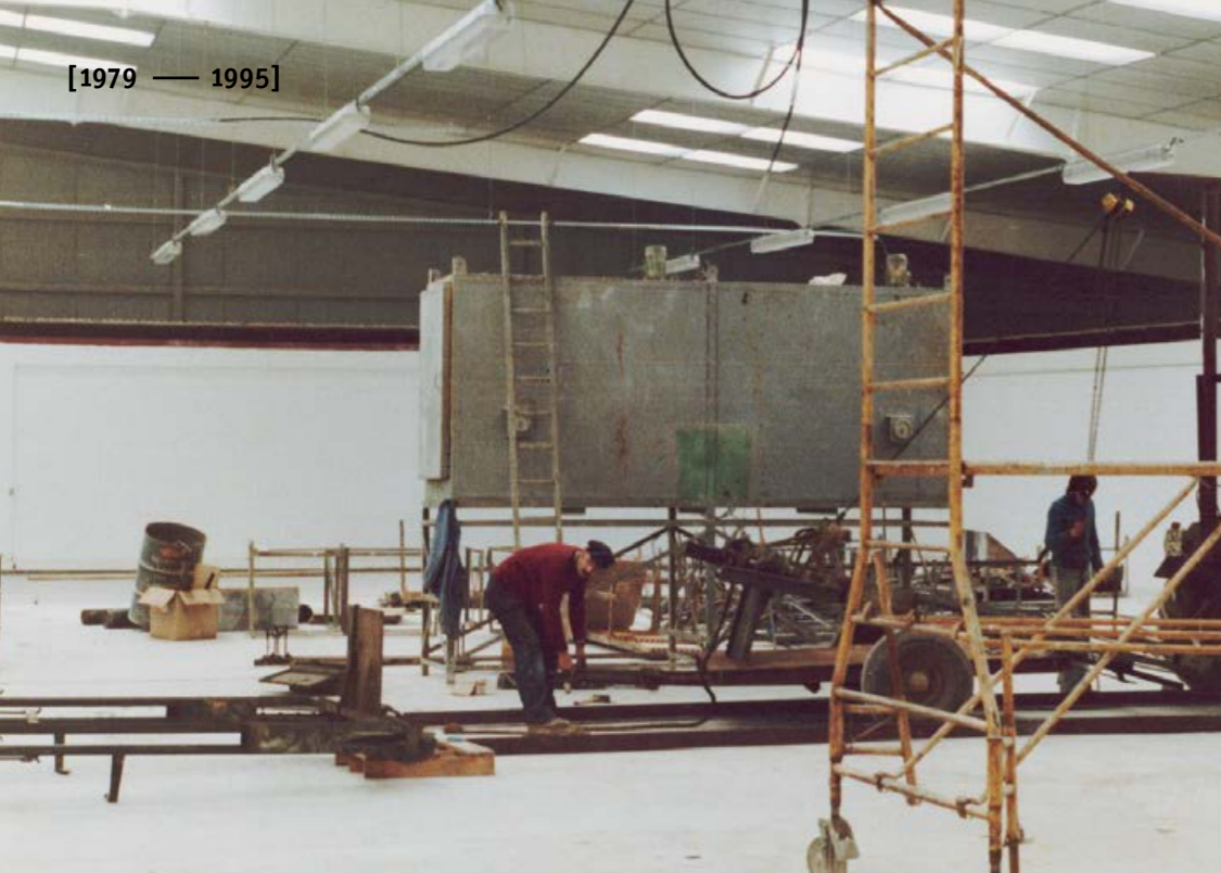
► Construction de l'usine (émulsion) à Port-en-Bessin
